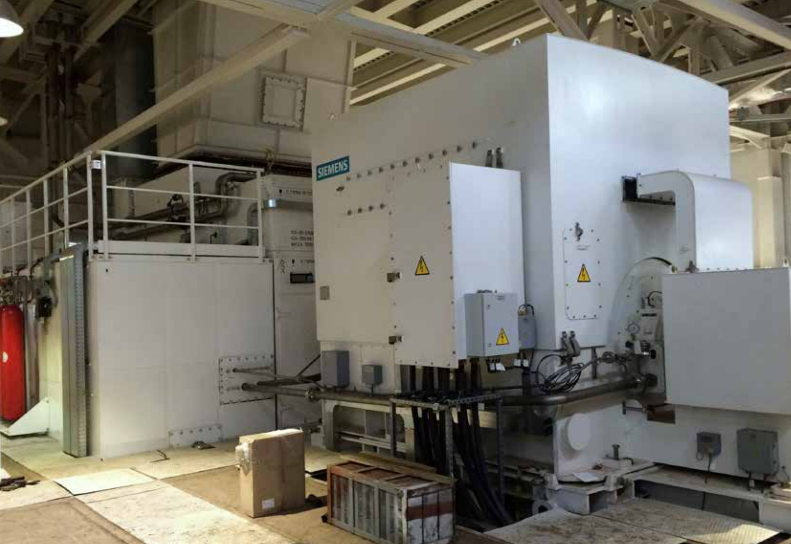
Для выработки электроэнергии использован генератор синхронный четырехполюсный типа 1DY2068-8AD02-Z производства фирмы Siemens.
