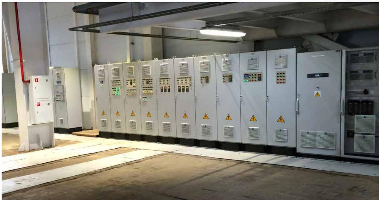
CAU и НКУ газотурбинной установки
