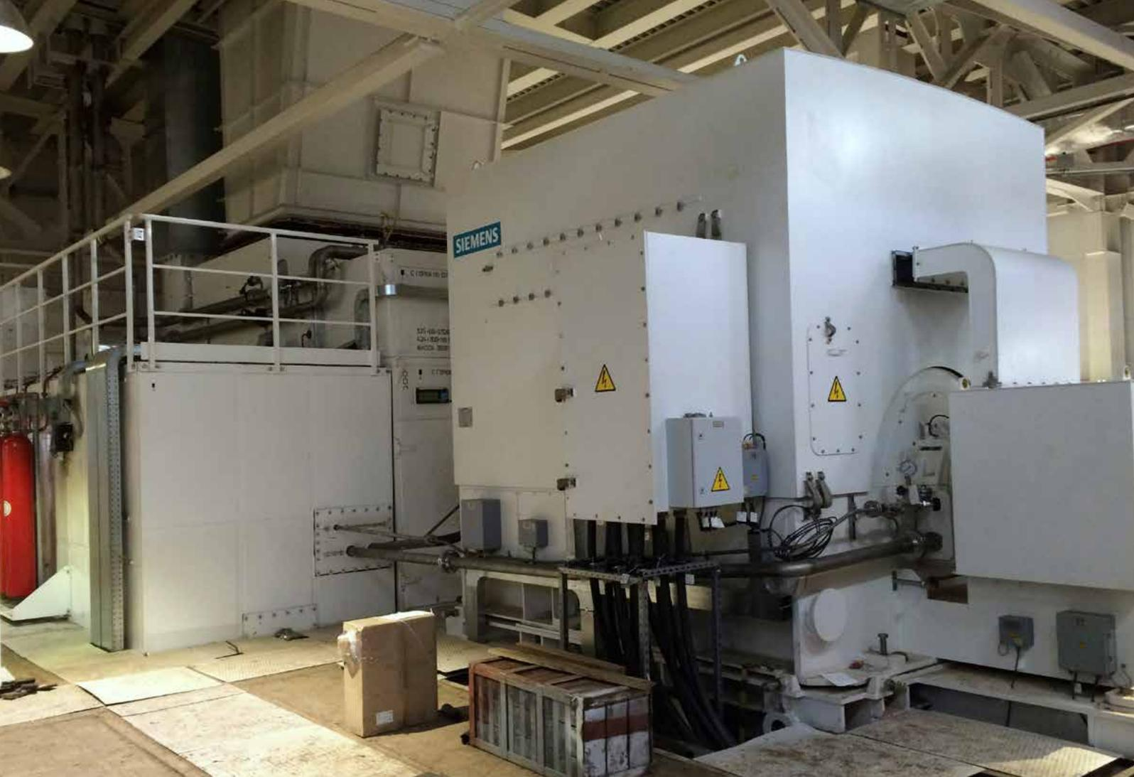
Для выработки электроэнергии использован генератор синхронный четырехполюсный типа 1DY2068-8AD02-Z производства фирмы Siemens.
